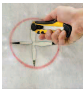
Przed zainstalowaniem elementów podstawowych należy wyciąć otwór dla dostępu rewizyjnego.
