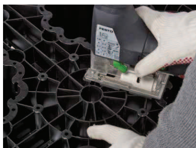
Przed zainstalowaniem elementów podstawowych należy wyciąć otwór dla dostępu rewizyjnego.
