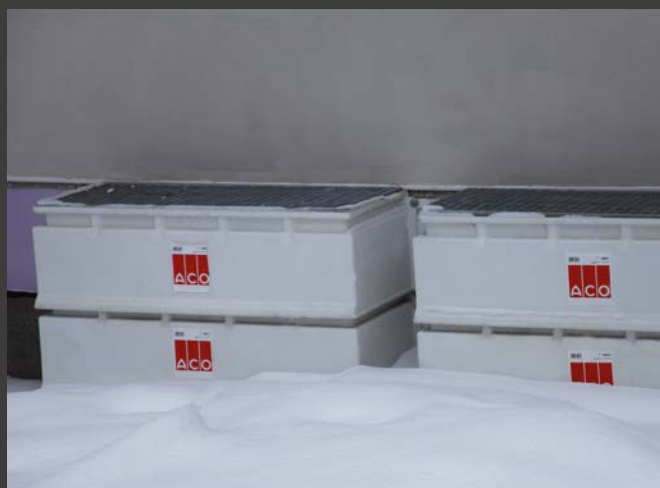
Zainstalowane doświetlacze ACO Therm® z nadstawkami dla regulacji wysokości.
