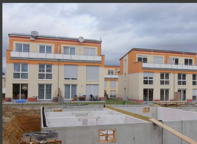
Nowy budynek na osiedlu mieszkaniowym Pinderpark blisko Zirndorfz 420 domkami szeregowymi i bliźniaczymi wybudowanymi zgodnie ze standardami niskoenergetycznymi.
