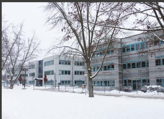
Centrum technologii BioPark III Regensburg znajduje się w bezpośrednim sąsiedztwie uczelni wyższej.
