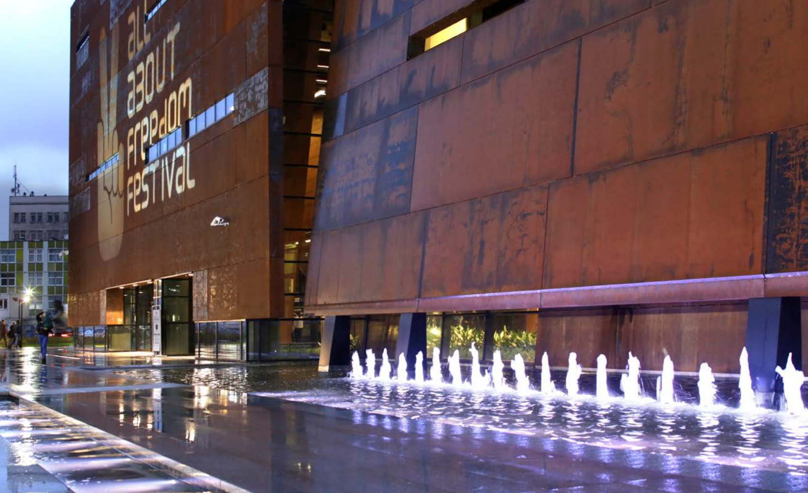
Zachodnia strona gmachu ECS z fontannami i iluminacją świetlną.
