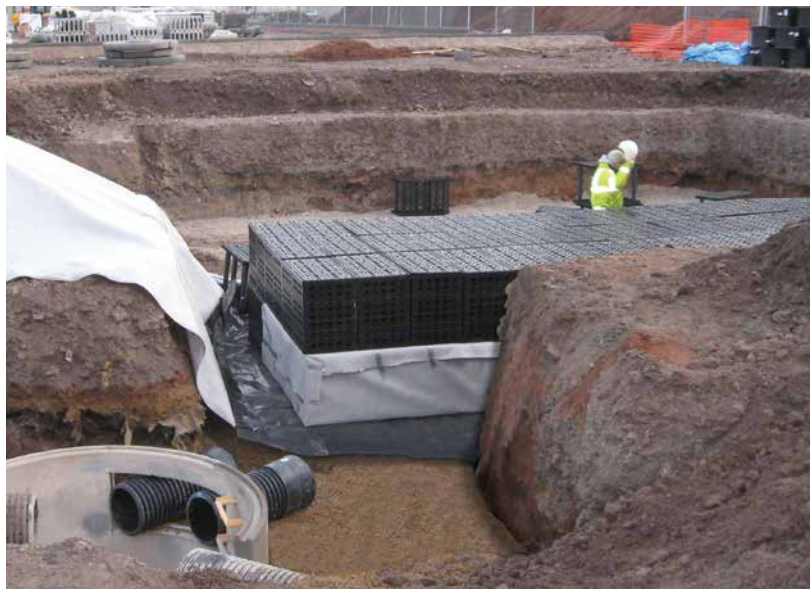
System retencyjny ACO Stormbrixx z regulatorem przepływu Q-Brake Vortex
