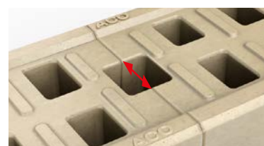
Mniejszy otwór wlotowy na połączeniu kanałów
