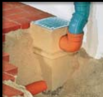
wpust z nadstawką odprowadzający wodę z rynny dachowej
