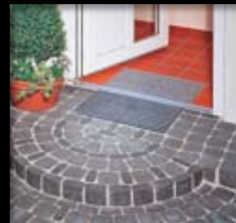
połączenie specjalnej wycieraczki z systemem odwodnienia umożliwia odprowadzanie wody sprzed drzwi wejściowych
