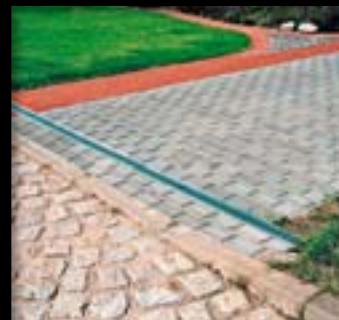
ruszt jest jedynym widocznym elementem systemu odwodnienia liniowego (na zdjęciach powyżej — odwodnienie liniowe chodnika)
