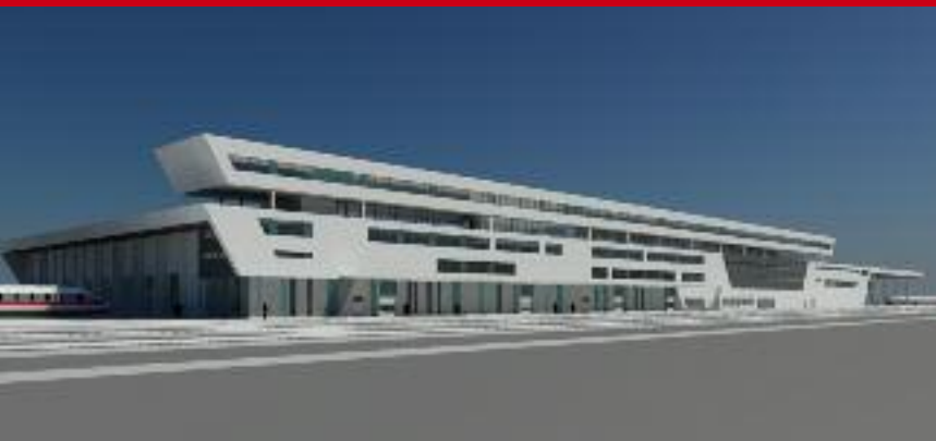
Dworzec kolejowy Matzleinsdorf, Wiedeń 1 600 m kanału XtraDrain z rusztem z tworzywa sztucznego
