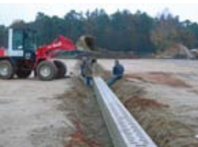
ACO DRAIN® Monoblock RD 300 D na lotnisku
