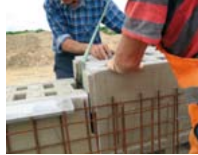
Układanie odwodnienia ACO DRAIN® Monoblock RD 300 D
