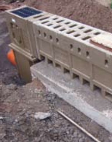
ACO DRAIN® Monoblock RD 300 instalowany na autostradzie A3 w Kolonii
