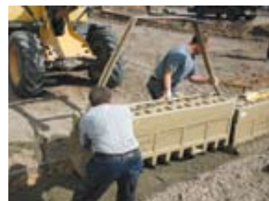
ACO DRAIN® Monoblock RD 300 podczas montażu
