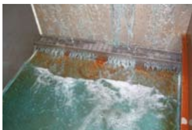
Próby korpusu kanału z rusztem kratowym 30 x 10 mm, swobodny przepływ z wyściółką na podporach
