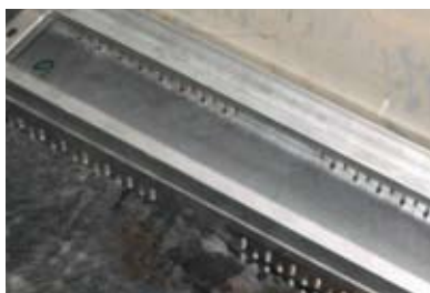
Zabudowa do próby z matą drenującą i podłożem ze żwiru łamanego przed korpusem korytka
