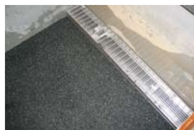
Podłoże ze żwiru łamanego 2/5 mm.
