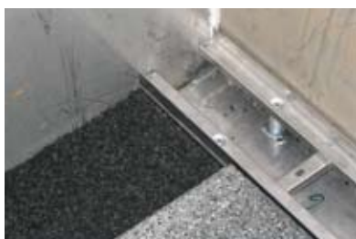
System kanału jest swobodnie położony
