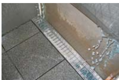
Zalewanie kanału elewacyjnego w zabudowie
