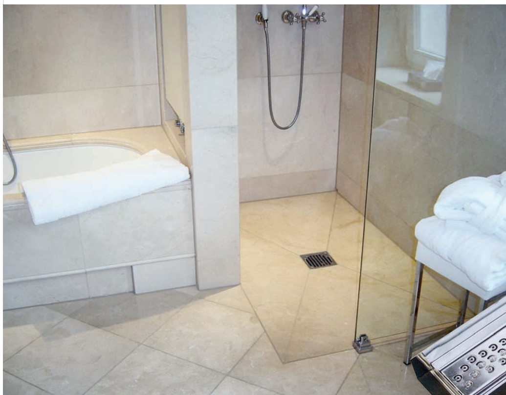
Wpusty podłogowe „Easyflow” wyróżniają się wymowanym syfonem.
