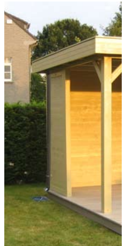
Przykład odwodnienia altany ogrodowej
