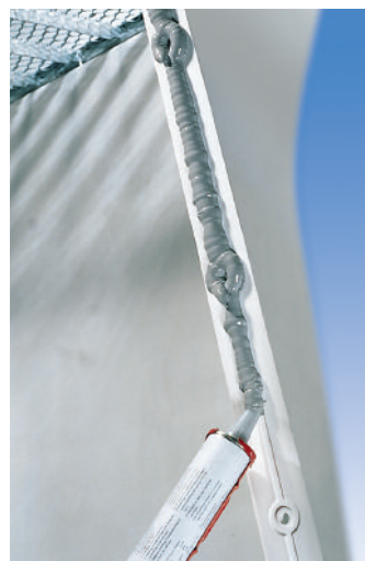
Nanoszenie masy uszczelniającej
