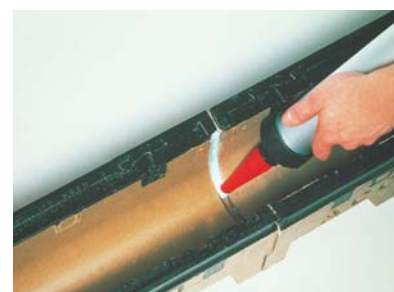
Wypełnienie bezpiecznej fugi masą uszczelniającą systemu ACO
