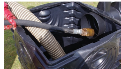
ACO Qmax® zdjęcia z demonstracji czyszczenia kanałów podczas testów przeprowadzonych przez ACO
