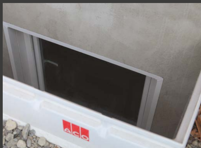
ACO Therm® przeciwpowodziowe uchylne okno piwniczne i doświetlacz.
