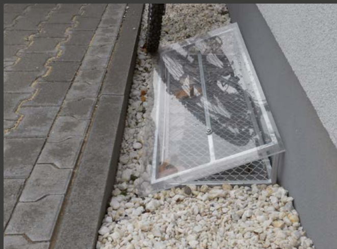
ACO Therm® uchylne okno i doświetlacz piwniczny wraz ze szklaną pokrywą chroniącą przed wodą deszczową.
