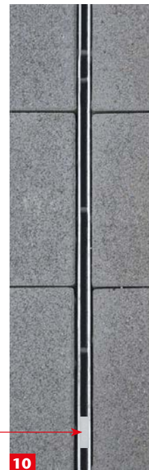
Przykład montażu specjalnej złączki do rusztów szczelinowych.
