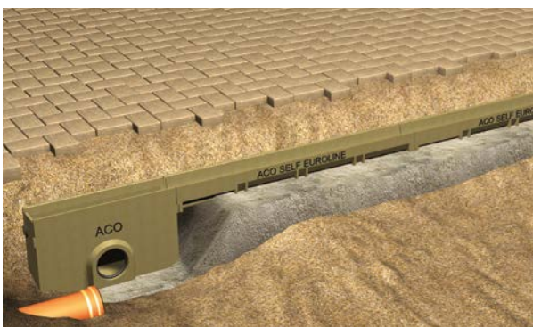
3. Układać korytka zaczynając od odpływu.
