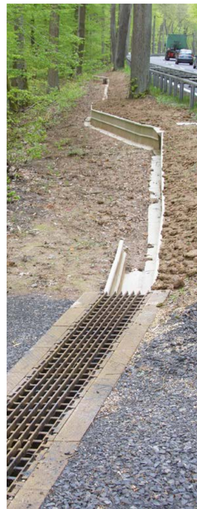
Montaż stoprywny w ścieżce żwirowej
