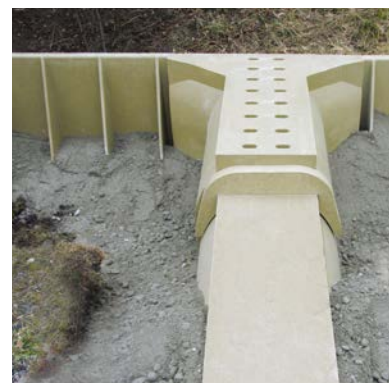
Montaż paneli wejściowych i ścianek naprowadzających
