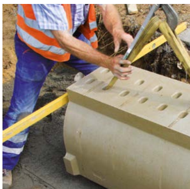
Układanie tunelu ACO PRO KT 500
