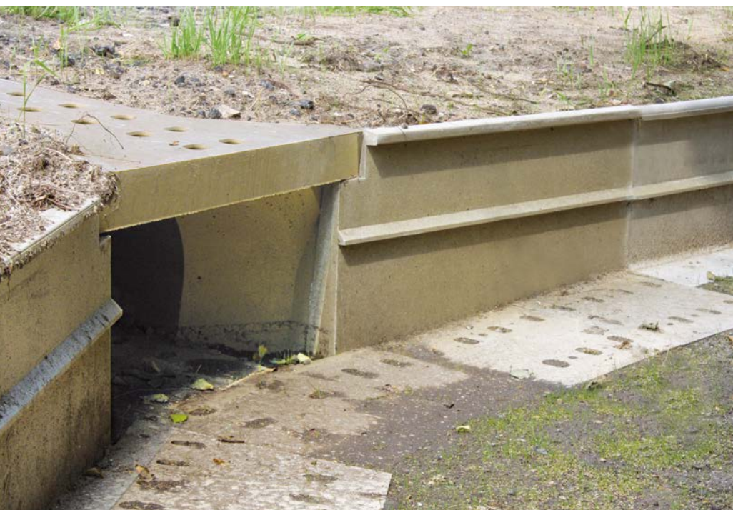
Ścianka naprowadzająca ACO PRO LEP 100, element wejściowy
