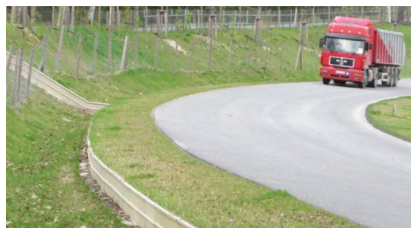
Instalacja w poboczu drogi
