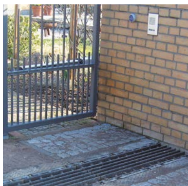
Rozwiązanie specjalne ze stoprynną pod ścianą
